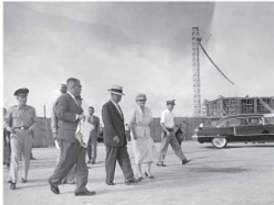
◎ 1959 이승만대통령 김포공항 건설현장 시찰
